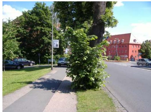
Bei der Mittelinsel muss auf beiden Straßenseiten eine **Bordsteinabsenkung** vorgenommen werden. Außerdem muss der Grünstreifen auf der Breite der Mittelinsel befestigt werden.
