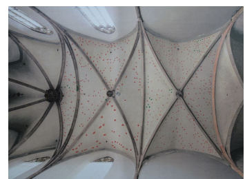
Bild 8: Gewölbe im Chor
