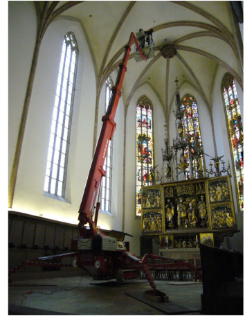
Bild 9: Einsatz eines Hubsteigers zur Untersuchung der Gewölbe
