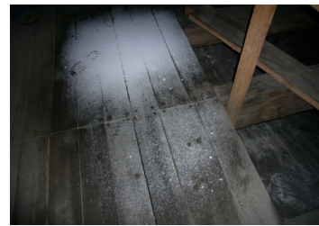
Bild 10: Schnee im Dachgeschoss
