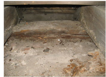
Bild 3: Zerstörte Mauerlatte
