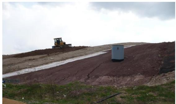
*Bauarbeiten zur Aufbringung der temporären Oberflächenabdichtung am Entsorgungs-Zentrum-Schwabach (aufgenommen im April 2008). Mittlerweile ist im wahrsten Sinne des Wortes Gras über die Abdeckung gewachsen (siehe Bild unten links vom Juni 2011).*
