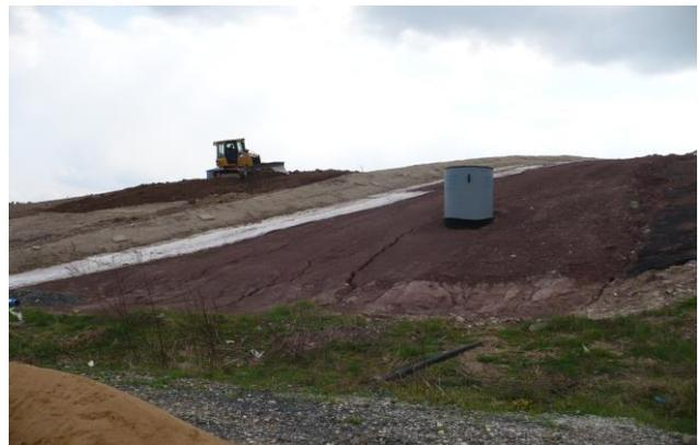
*Bauarbeiten zur Aufbringung der temporären Oberflächenabdichtung am Entsorgungs-Zentrum-Schwabach (aufgenommen im April 2008). Mittlerweile ist im wahrsten Sinne des Wortes Gras über die Abdeckung gewachsen (siehe Bild unten links vom Juni 2011).*
