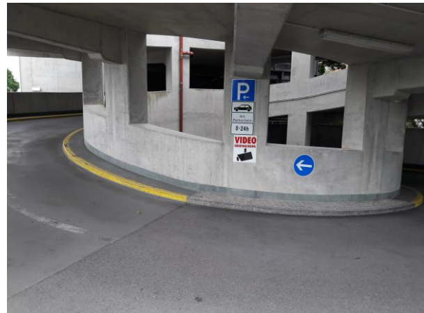
Nördliche Rampe (aufwärts)
