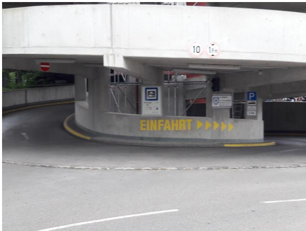
Südliche Rampe (abwärts)
