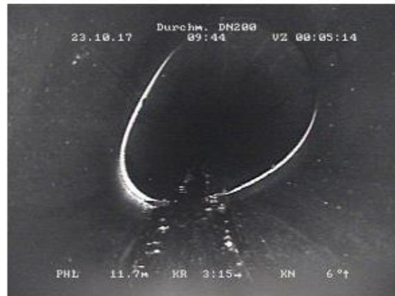
Foto-Nr. 14 11,7m 00:05:14 D--L Deformation biegeweicher Rohra, linker Kämpfer, Red. Querschn. 30%
