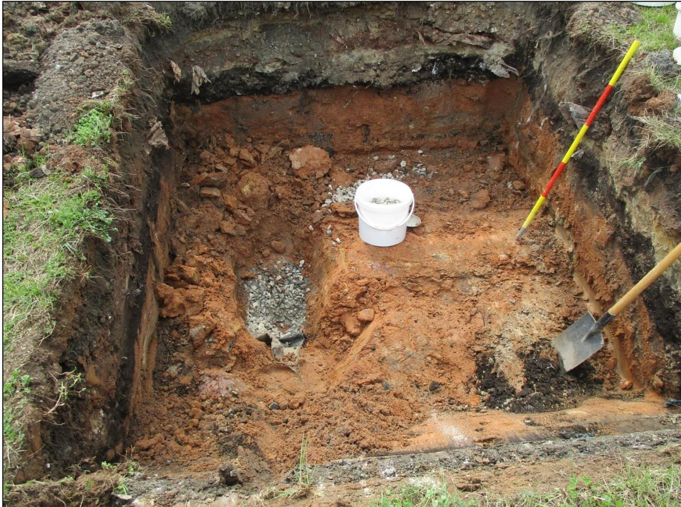
Die Dränschicht ist mit einem Geotextil abgedeckt und daher gut von der Reku-Schicht getrennt. Allerdings wird das Geotextil beim maschinellen Aushub zerstört werden. Damit werden sich Reku-Material und Schotter vermischen.
