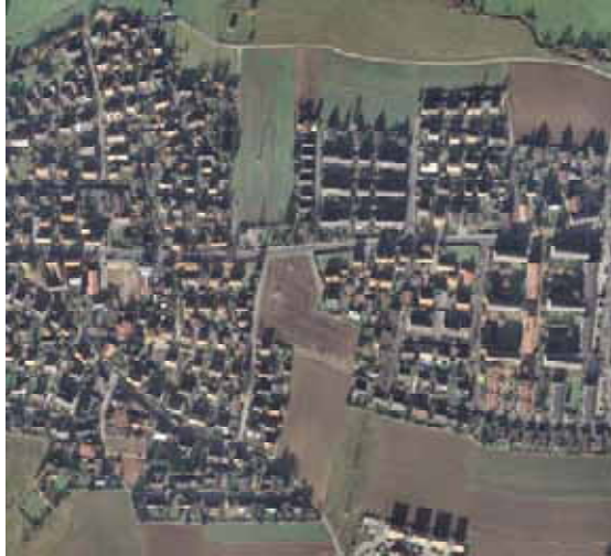
Orthofoto 27 Entlang der Hochspannung östlich Unterreichenbach
