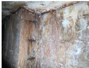
Starke Korrosion an Beckenwänden im KG
