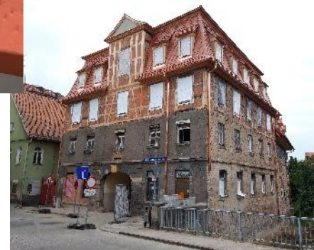
Planung: Helmut Rester Restaurator: Holger Wilcke
