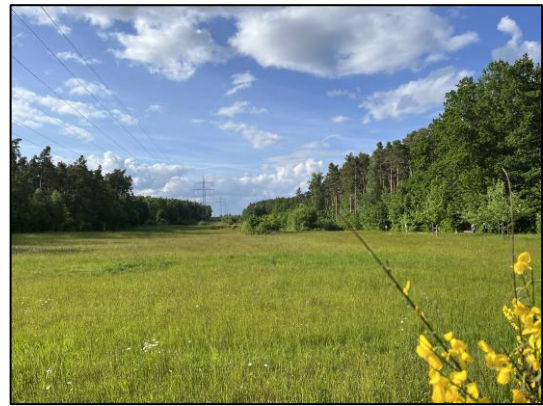
Abbildung 5: Leitungstrasse in der Brünst mit Blick auf den Wald
