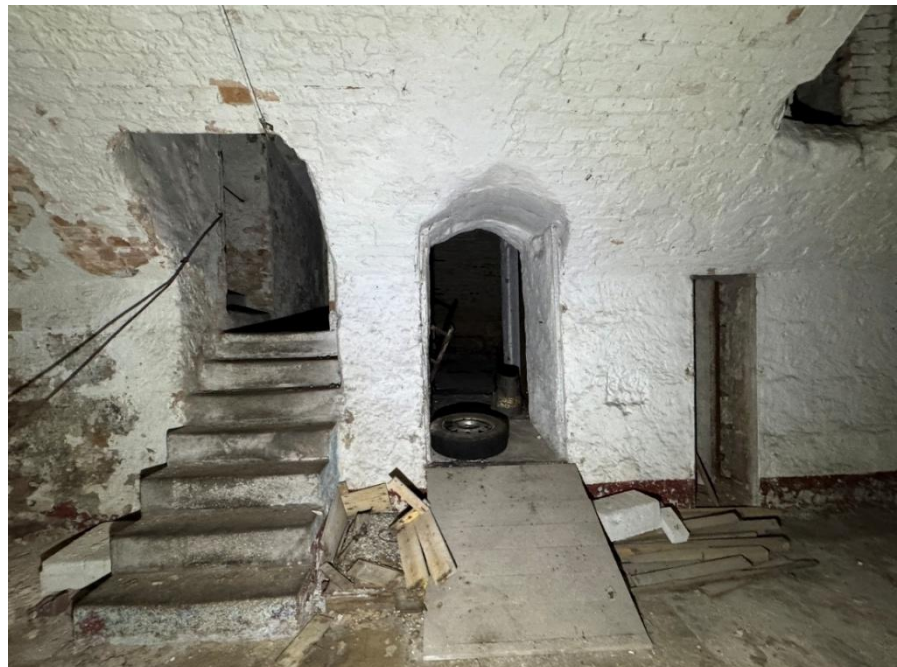
Abb. 75 – Zugangssituation in den westlichen Gewölbekeller mit Verbindungsgang in den östlichen Kellerraum, um 1865.
