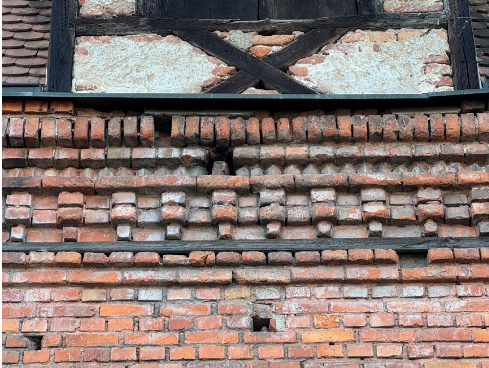
Abb. 22 – Detailausschnitt Schmuckgesims im Traufbereich der Ostfassade, um 1895.
