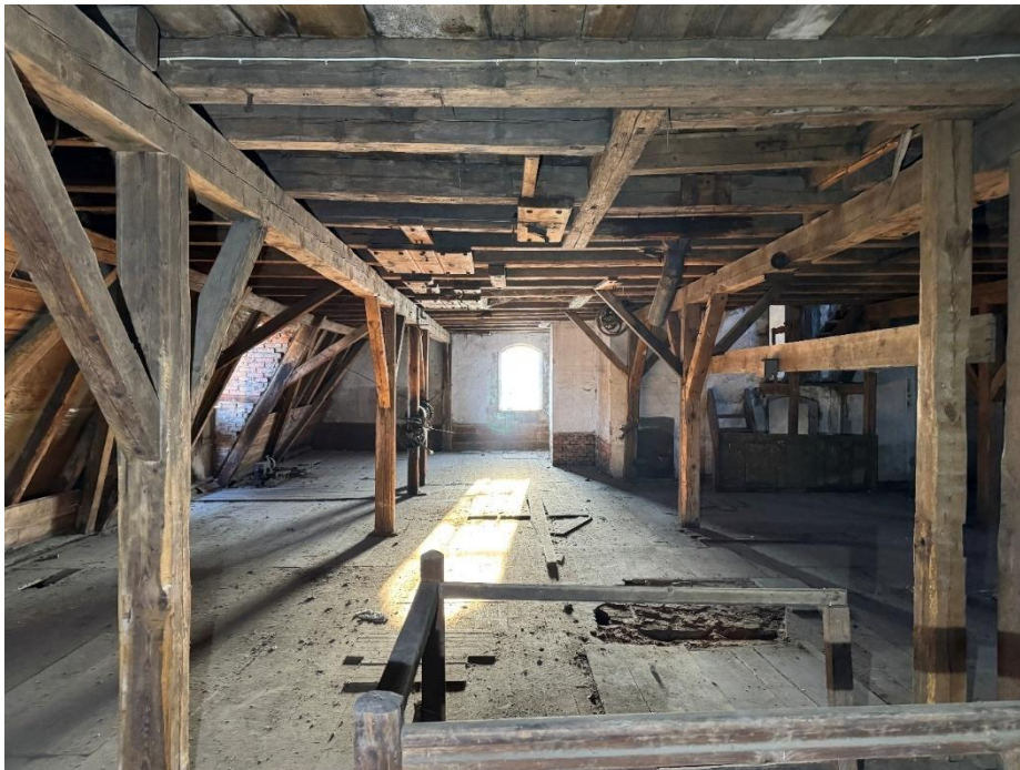
Abb. 66 – Blick in den südlichen Dachraum des Hauptbaues.
