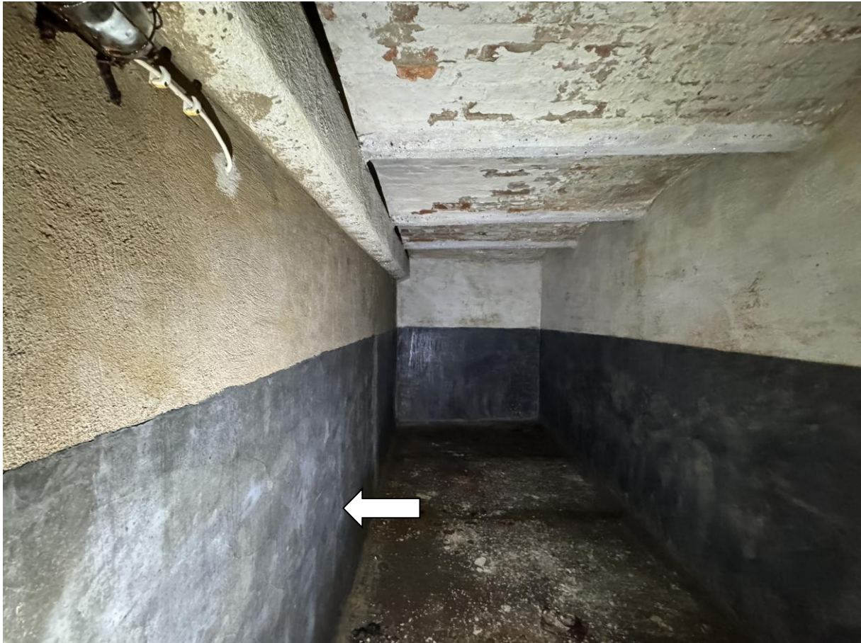
Abb. 11 – 1. Untergeschoss, Kellerraum 2, Mitte 20. Jh.
