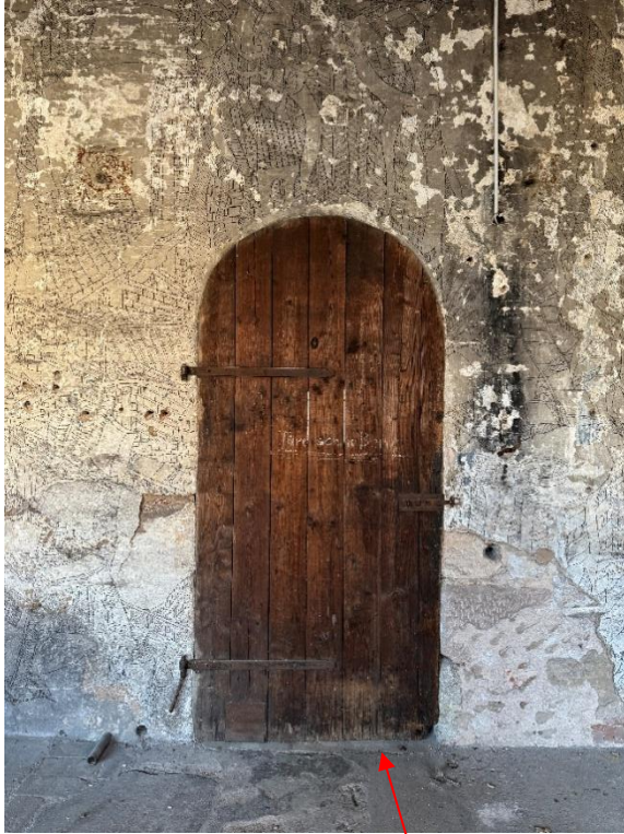
Abb. 33 – Haupthalle 0.1, Zugangstüre, um 1865
