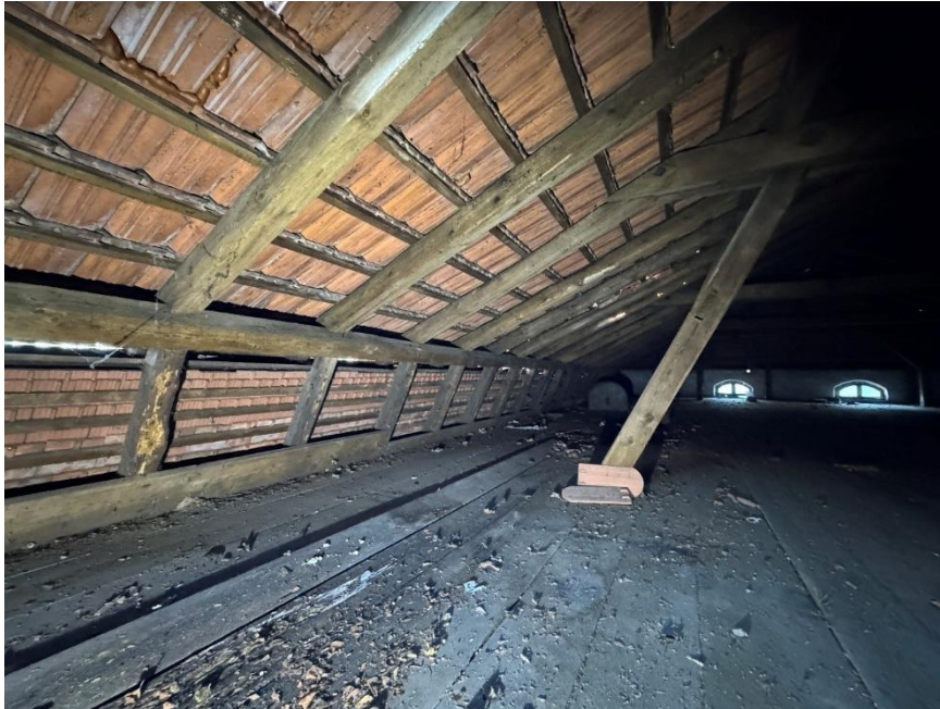
Abb. 72 – Blick in den östlichen Spitzboden.
