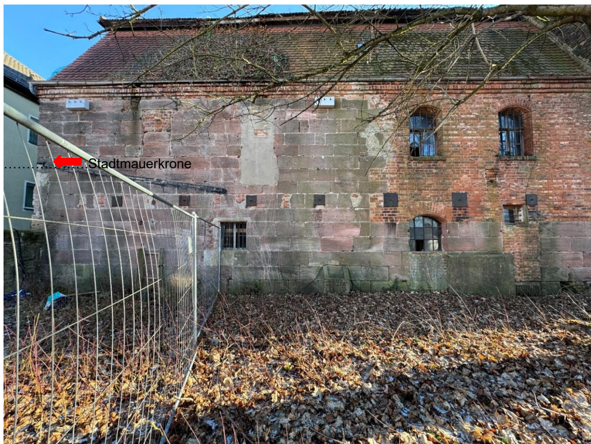
Abb. 16 - Westfassade mit Quadersandsteinmauerwerk, um 1865; Sichtziegelmauer, um 1895
