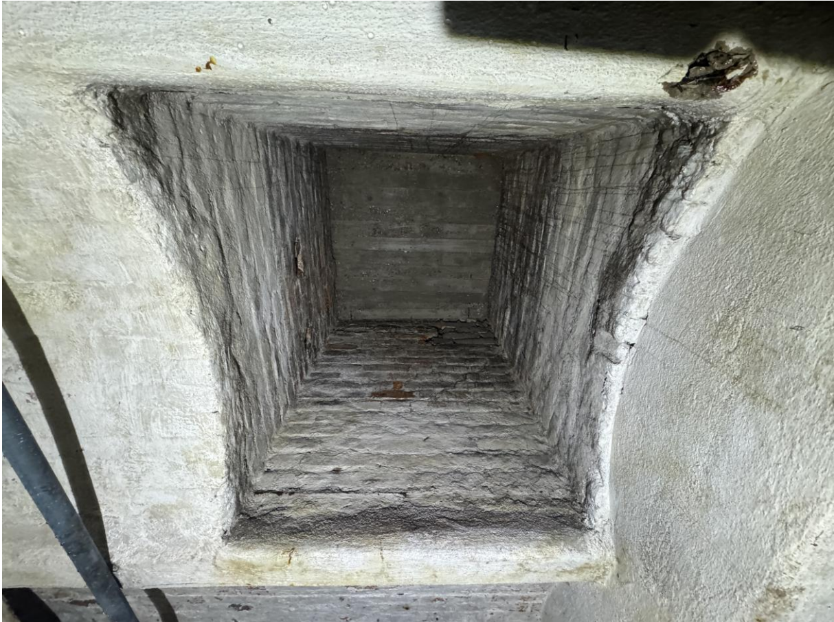
Abb. 10 – 1. Untergeschoss, Kellerraum 1, Mitte 20. Jh.,
