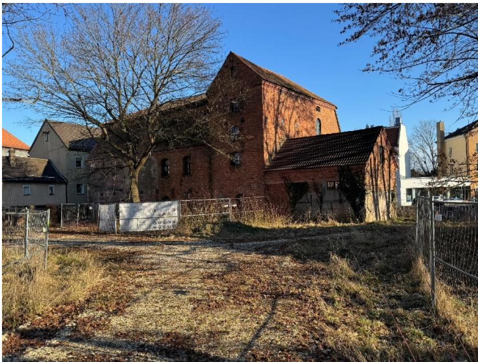
Abb. 29 – Südwestansicht der ehem. Mälzerei.
