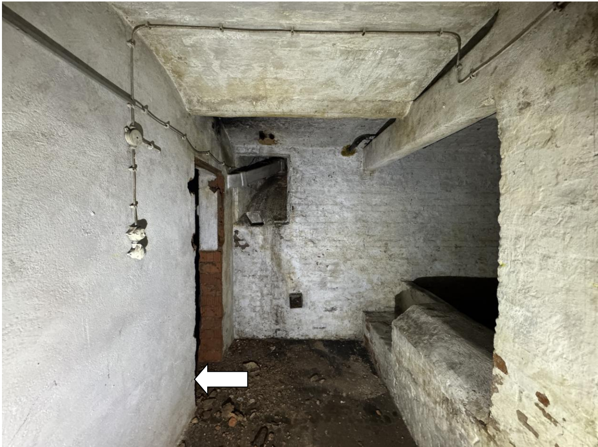
Abb. 9 – 1. Untergeschoss, Kellerraum 1, Mitte 20. Jh.
