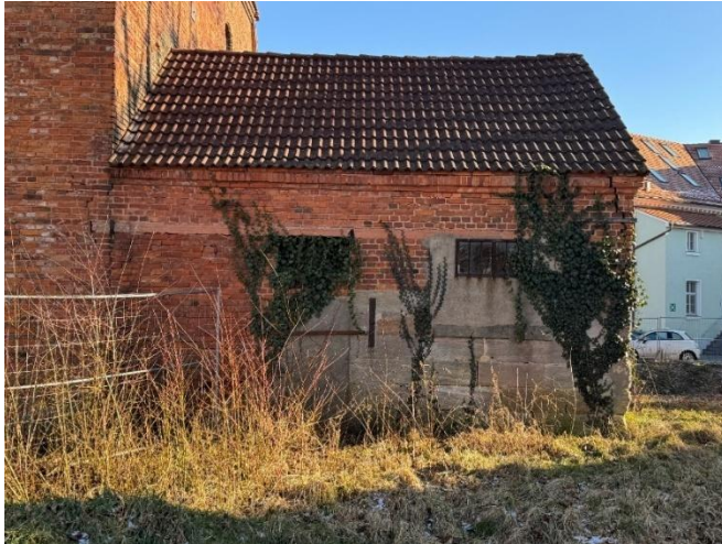
Abb. 27 – Westansicht – südlicher Anbau
