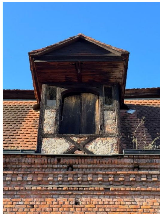
Abb. 22 – Detailausschnitt Schmuckgesims im Traufbereich der Ostfassade, um 1895.
