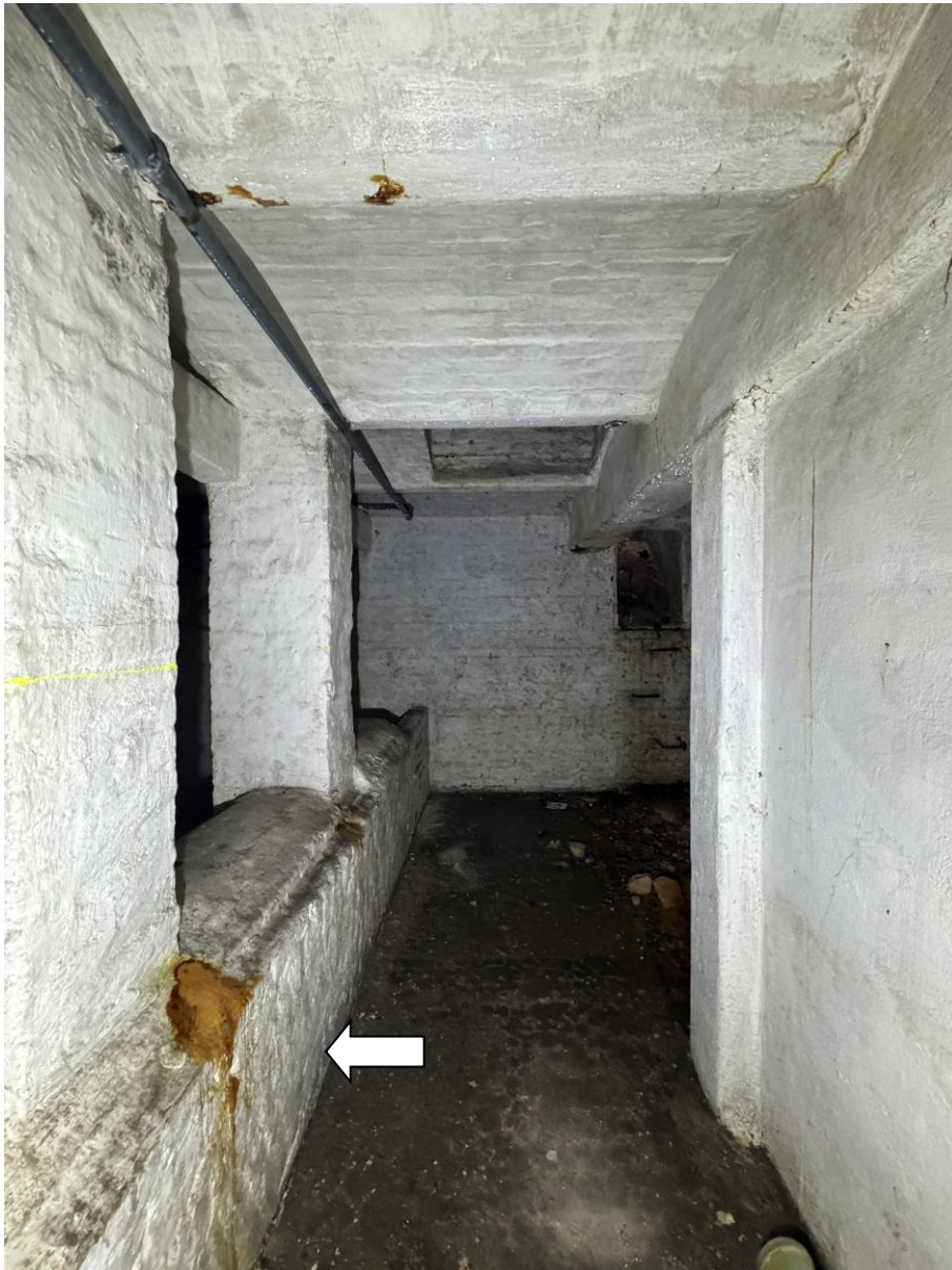
Abb. 8 – 1. Untergeschoss, Kellerraum 1, Mitte 20. Jh.
