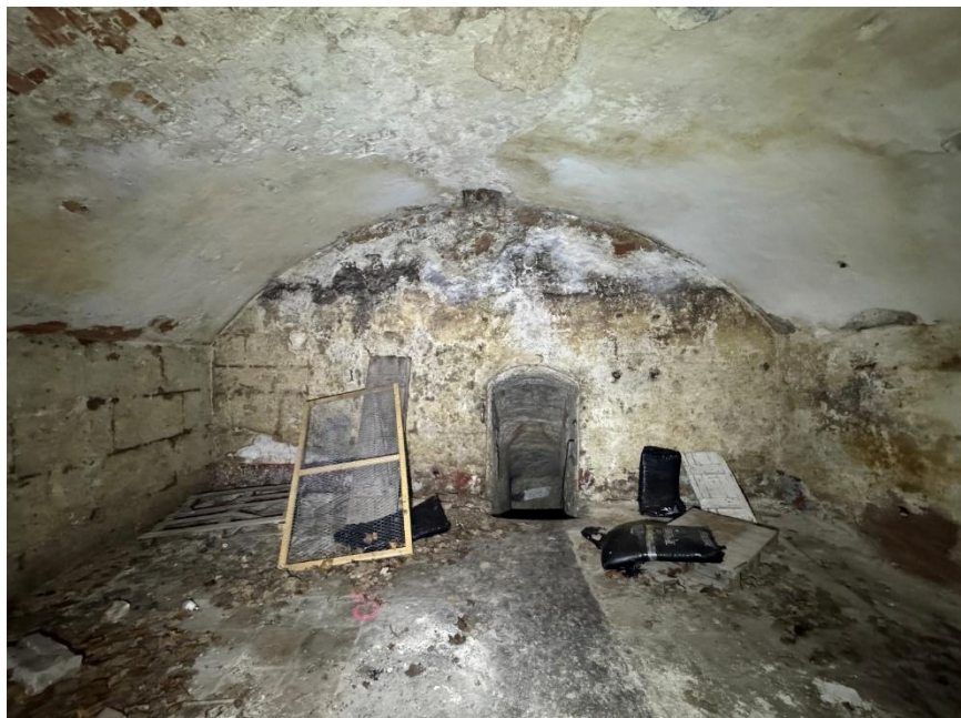
Abb. 77 - Westlicher Kellerraum mit Quadersandsteinwänden und geziegeltem Flachtonnengewölbe und Zugangsöffnung in das nördliche Felsenkellersystem.
