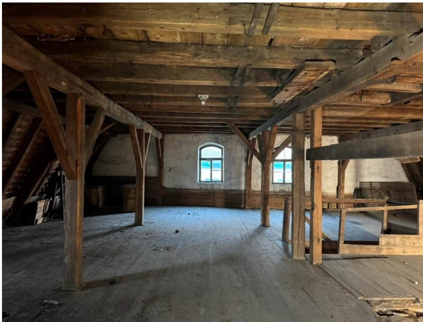
Abb. 64 – Nördlicher Dachraum mit drei Binnenstützenachsen, um 1895.
