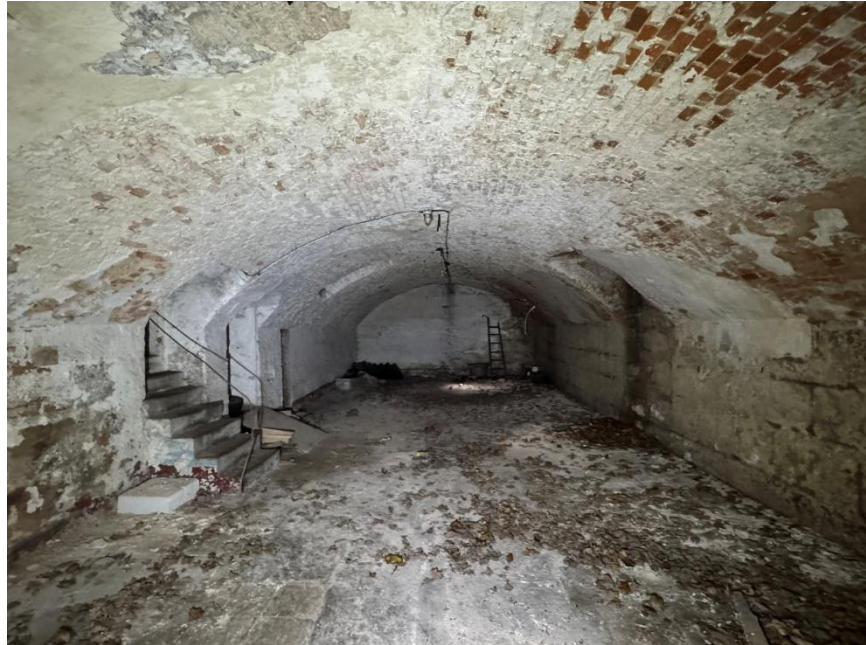
Abb. 76 – Westlicher Kellerraum mit Quadersandsteinwänden und geziegeltem Flachtonnengewölbe; Blick nach Süden.
