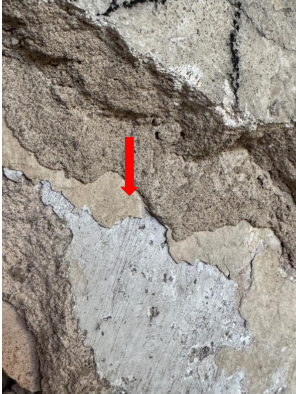
Abb. 35 und 36 - Haupthalle 01, Westwand a, Farbfassungsreste um 1865 (Pfeil).
