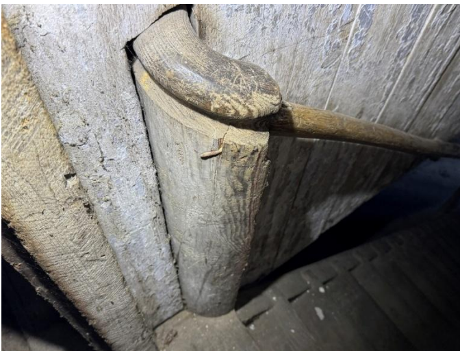
Abb. 55 – Treppenaustritt, Krümmling, um 1865
