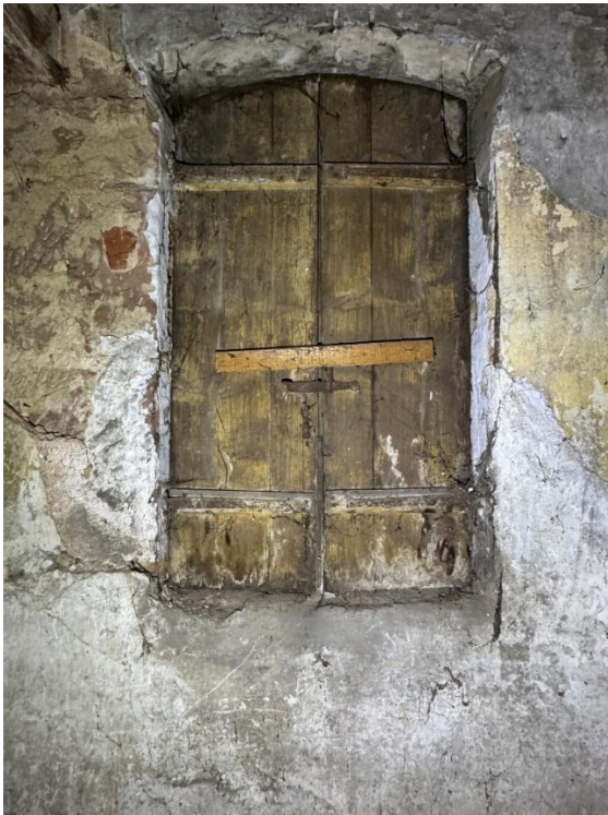
Abb. 47 und 48 - Raum 0.5; Wand b Fensteröffnung mit Holzläden, um 1865.
