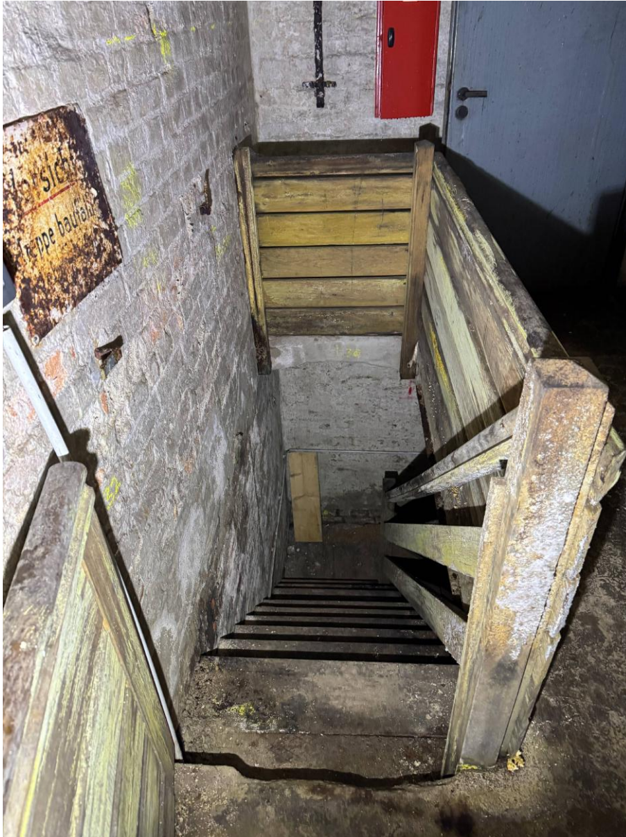
Abb. 5– Holzabgangstreppe mit Pilz- und Sporenbefall, Mitte 20. Jh. Der Abgangsbereich in das 2. Untergeschoss entstand samt Keller-räumen - soweit einsehbar - ebenfalls gegen Mitte des 20. Jh.
