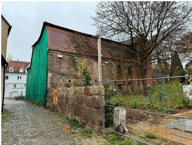
Abb. 10 – Nord- und Westfassade der Mälzerei
