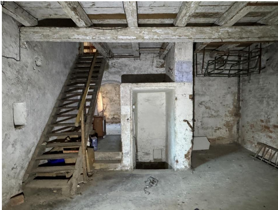
Abb. 45 – Raum 0.5 mit Zugangsstiege in das 1. Obergeschoß und Einhausung des Kellerabgangs.
