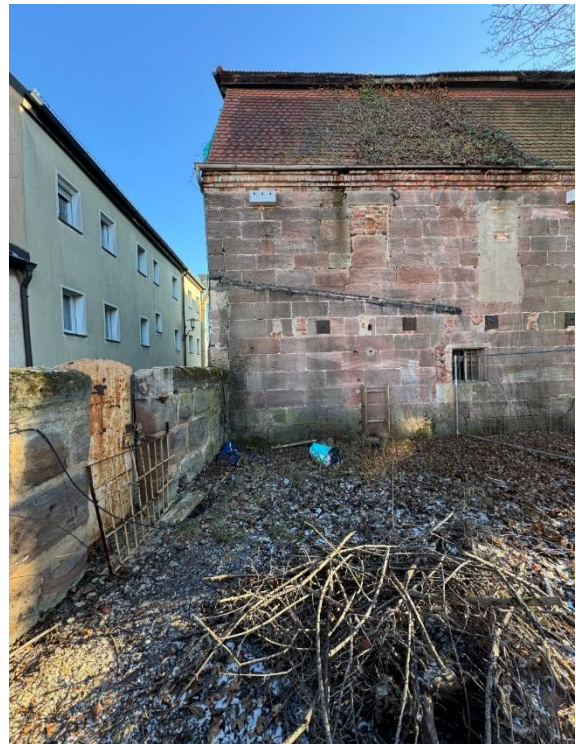
Abb. 19 – Teilausschnitt Westfassade mit Stadtmauer- rudiment
