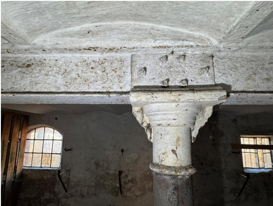
Abb. 44 - Raum 0.4, Wand a mit Eisenpfeiler und Kapitell sowie verschraubtem Winkelprofil.
