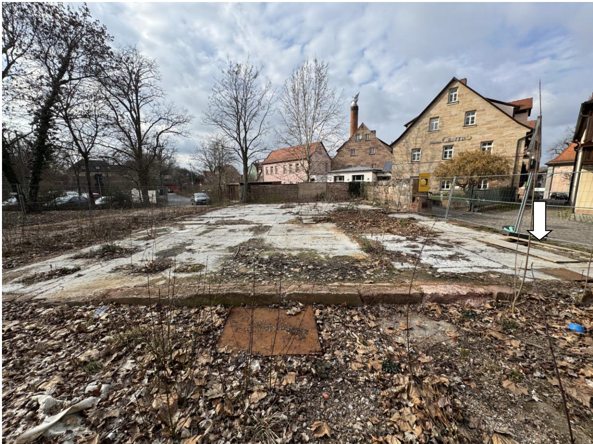
Abb. 2 – Bodenplatte des oberirdisch abgetragenen, ehem. Gebäudes Südliche Mauerstraße 7b mit Zugangsöffnung zur Kellertreppe (Pfeil).
