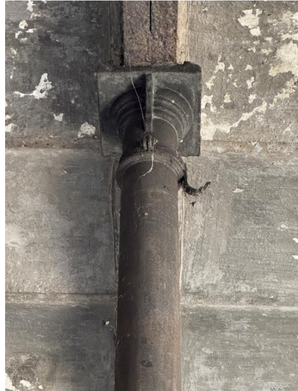
Abb. 33.1 – Gusseiserner Rundpfeiler
