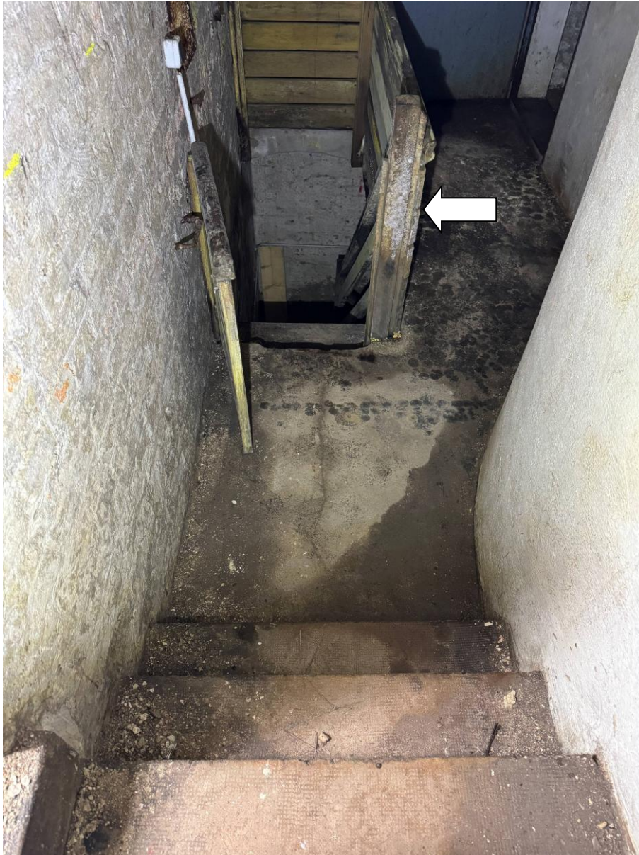
Abb. 4– Betontreppe im Austrittsbereich mit gemauerten Abgangswänden (Vollziegelmauerwerk verschlämmt), Mitte 20. Jh. Die einsturzgefährdete Holztreppe (Pfeil), welche in das 2. Untergeschoss führt ist in die gleiche Bauphase zu datieren.
