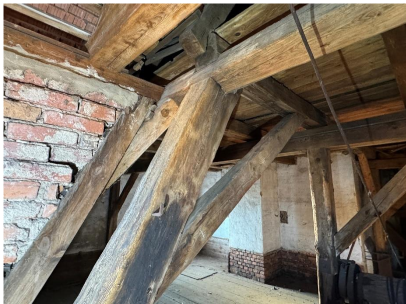
Abb. 69 – Knotenpunkt im Bereich des Kranzugerkers.
