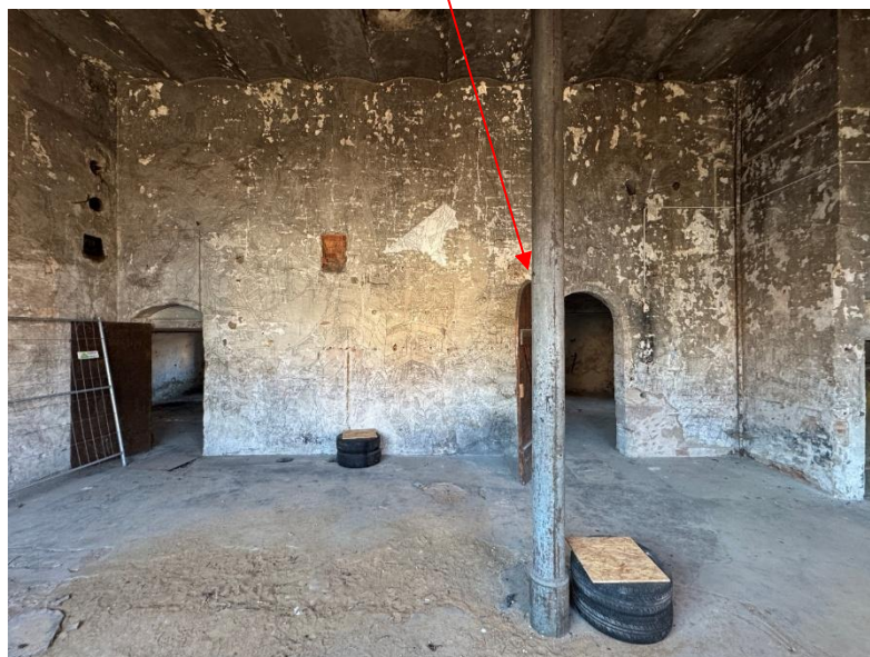
Abb. 34 – Haupthalle 01, Westwand a.
