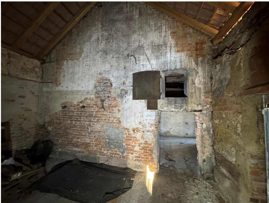
Abb. 52 - Raum 0.6, Wand b
