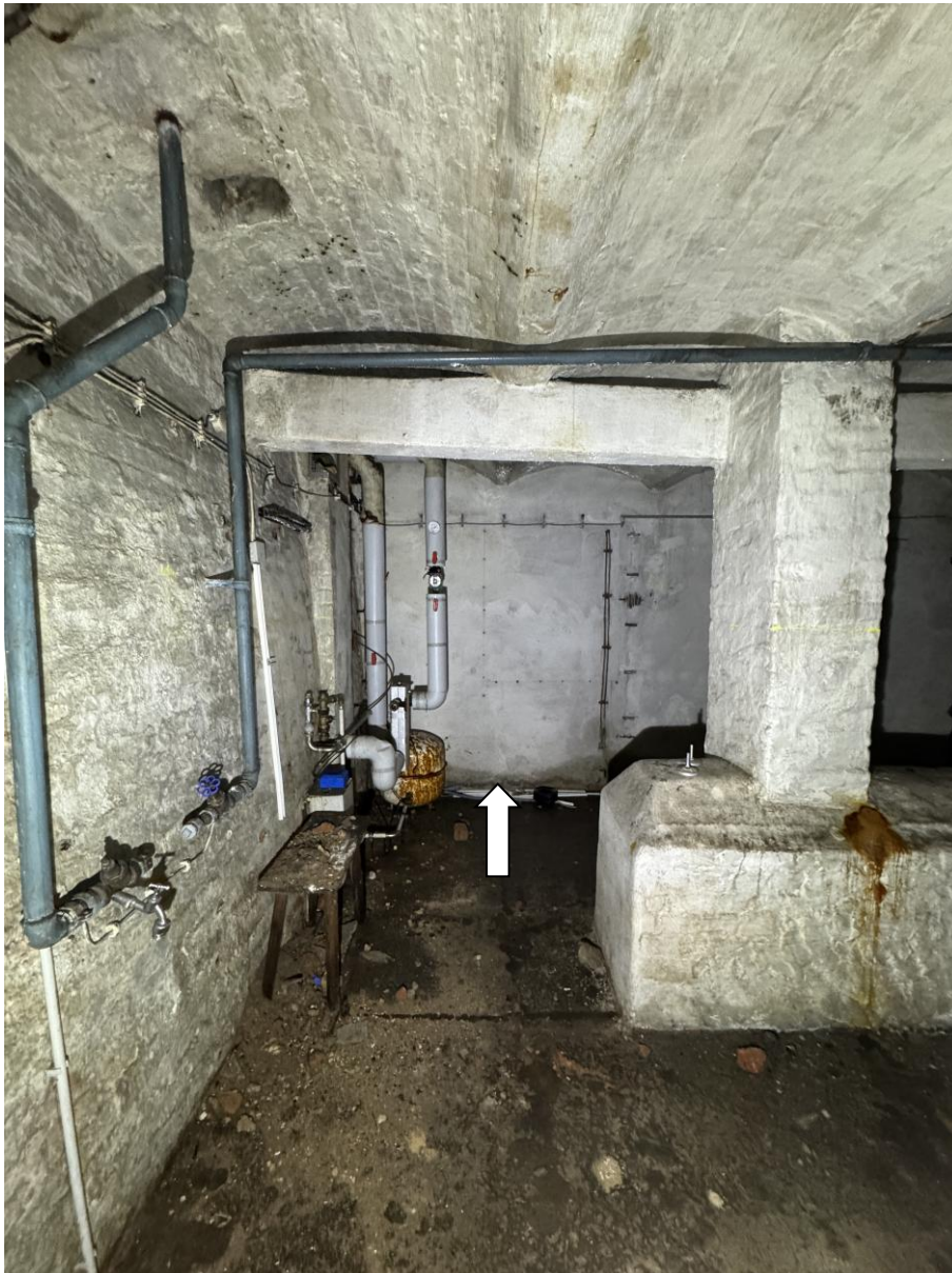
Abb. 7 – 1. Untergeschoss, Kellerraum 1, Mitte 20. Jh.
