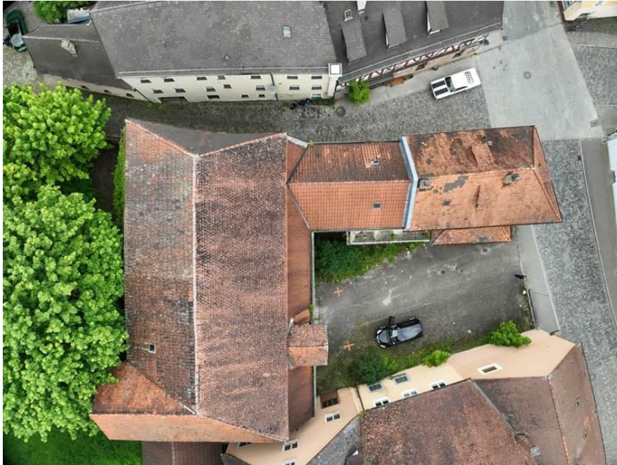
Abb. 2 und 3 Luftbildaufnahmen vor Abbruch der Hofgebäude Quelle: Arch Büro Klemm, Schwabach, 12/2024
