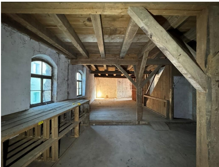
Abb. 57 - 1. Obergeschoss, westliche Lagerhalle, Blick in östlichen Winkelbau
