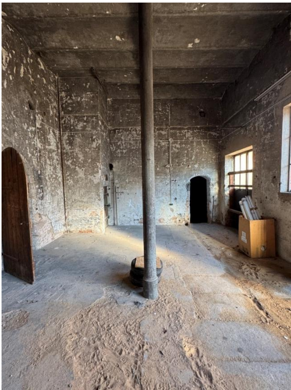
Abb. 31 – Haupthalle 0.1 Blick nach Norden
