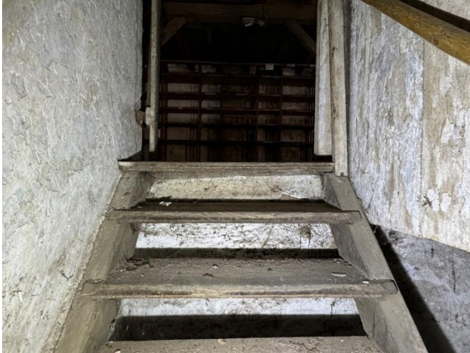
Abb. 54 – Aufgangsstiege von Raum 0.5 in das 1. OG
