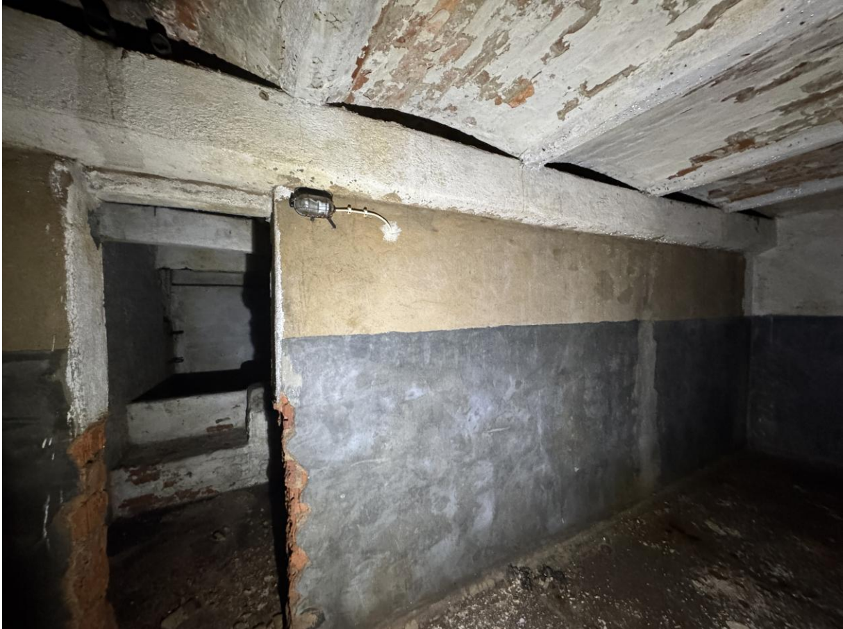
Abb.12 – 1. Untergeschoss, Kellerraum 2, Mitte 20. Jh.
