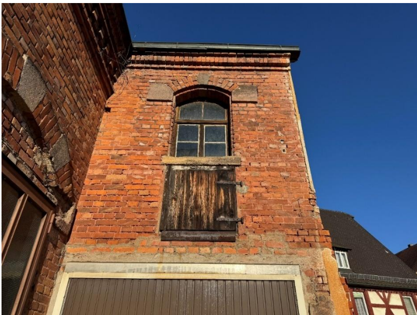
Abb. 21 – Südfassade des nordöstlichen Winkelbaues, um 1895
