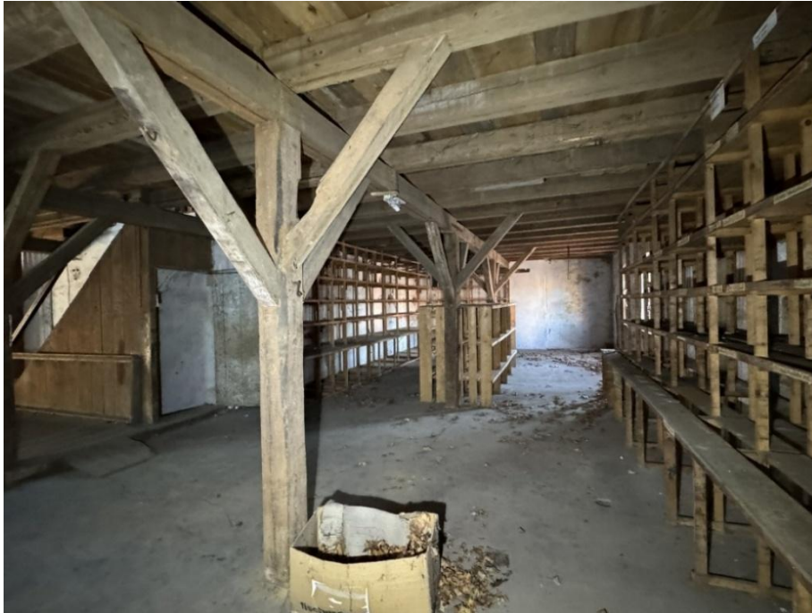
Abb. 56 – 1. Obergeschoss, westliche Lagerhalle, Blick nach Süden, um 1895
