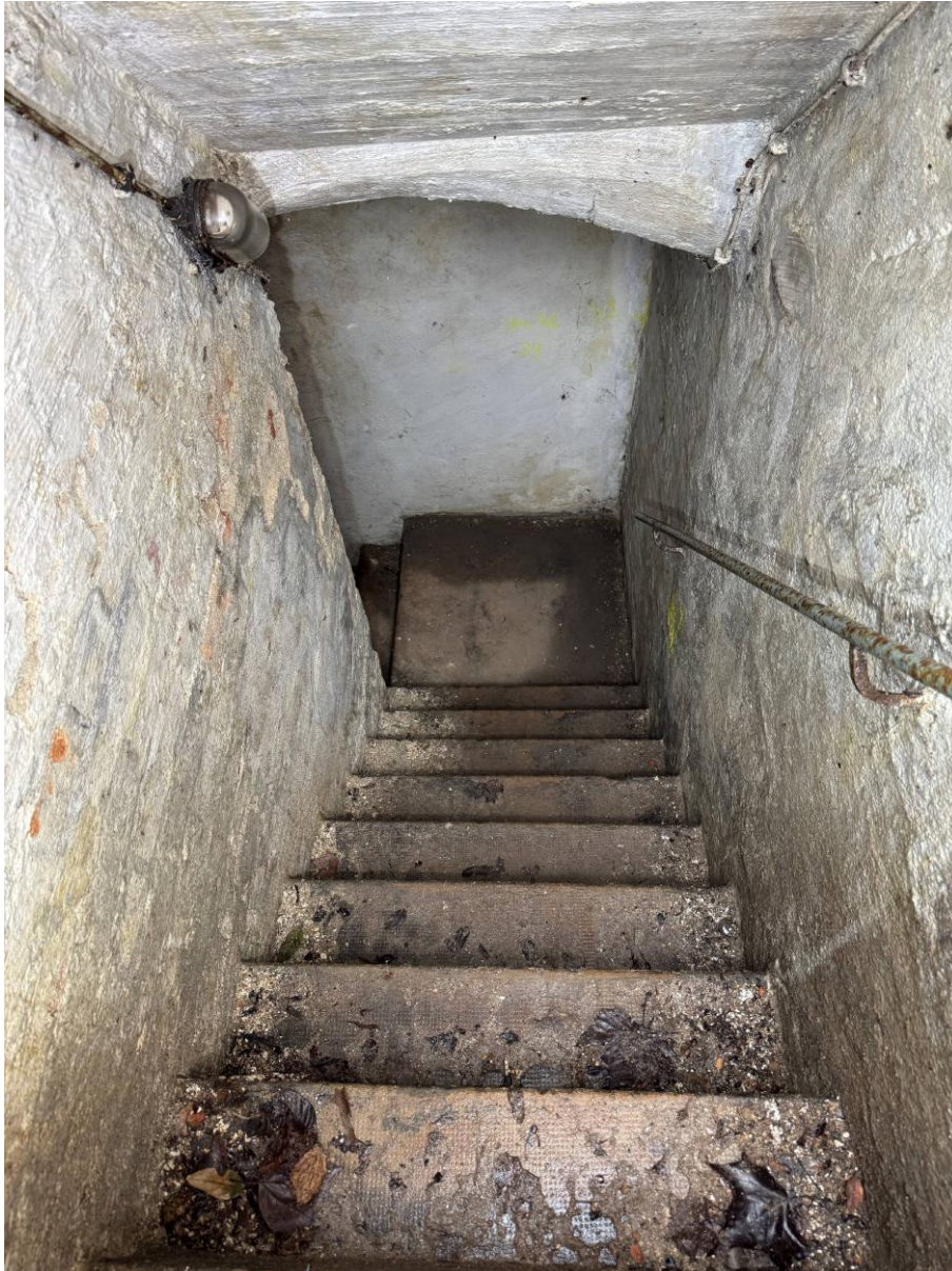
Abb. 3– Betontreppenanlage mit gemauerten Abgangswänden (Vollziegelmauerwerk mit Kalkputzaufgabe), Mitte 20. Jh. Der Kellerhals wurde als Ortbetonplatte ausgebildet, dto. Mitte 20. Jh.
