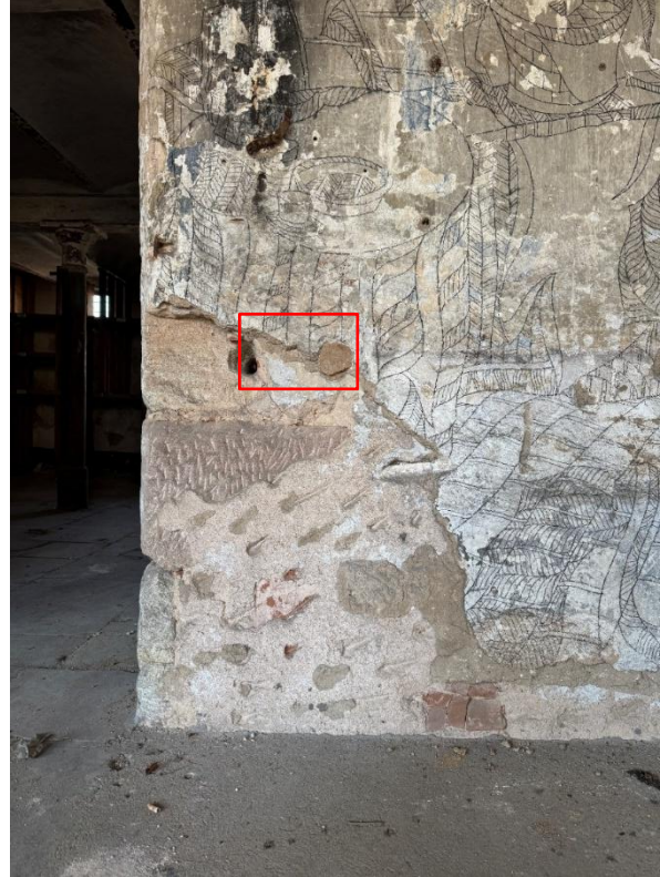
Abb. 35 und 36 - Haupthalle 01, Westwand a, Farbfassungsreste um 1865 (Pfeil).
