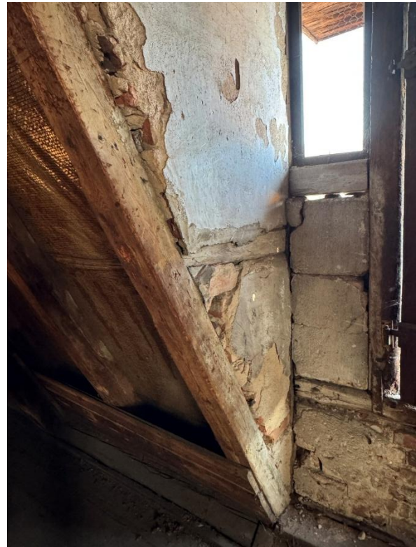
Abb. 68 – Nördliche Abseite des Kranzugerkers
