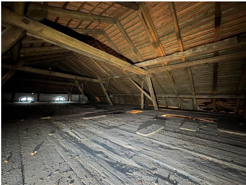
Abb. 73 - Blick in den westlichen Spitzboden.
