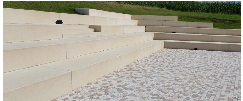
Sitzterrasse aus Beton
