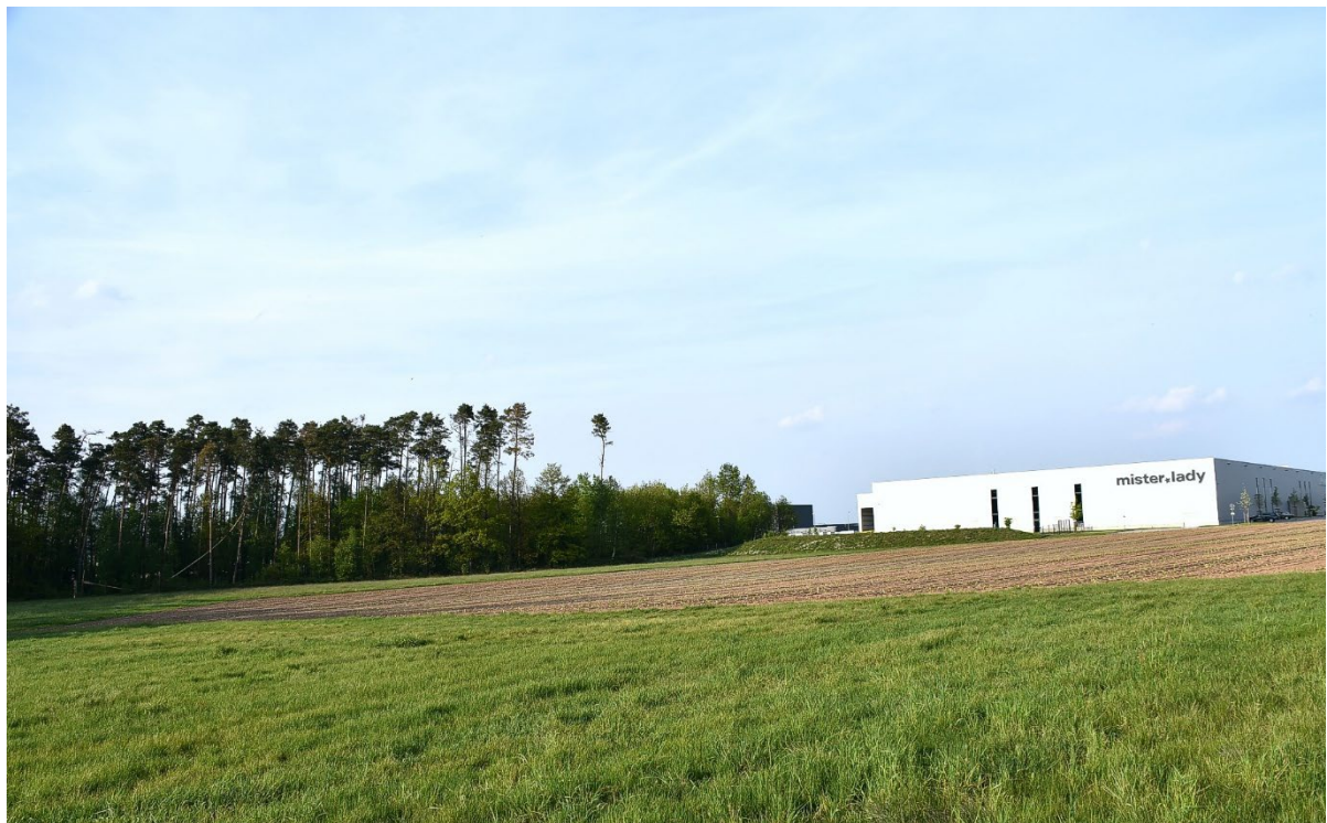
Abb. 2: Blick nach Osten über das Untersuchungsgebiet (Foto FEHSE 02.05.2025)
